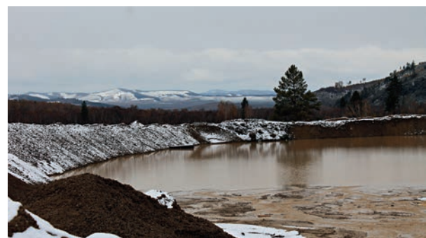
Auffangbecken für ungeklärte Abwässer aus Bergbau-Aktivitäten im Kharaa-Flusseinzugsgebiet, Mongolei
