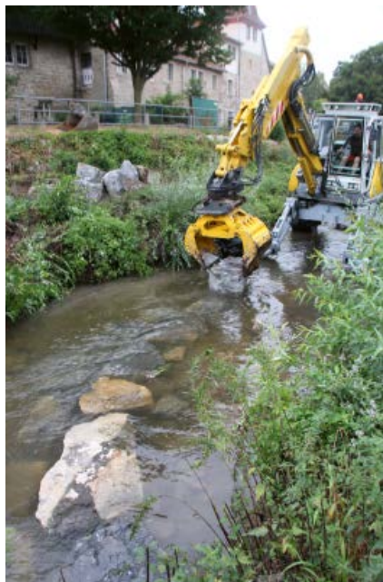
Abb. 1: Schreitbagger beim Setzen der Steine
