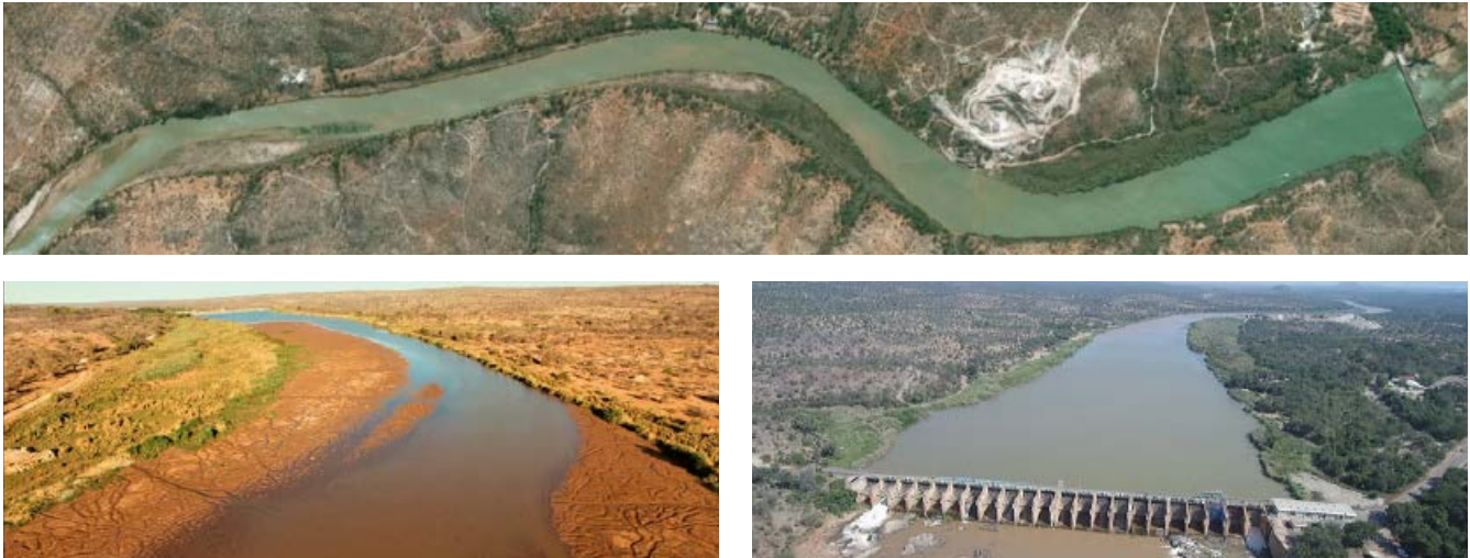
Abb. 1: Orthofoto der Phalaborwa Barrage (oben, © ESRI), trockengefallene Bereiche während Niedrigwasser Oktober 2019 (unten links, © Mohlala) und die Stauwehr mit 22 Drehsegmenttoren und dem Maschinenhaus (unten rechts, © DIE GEWÄSSER-EXPERTEN!)
